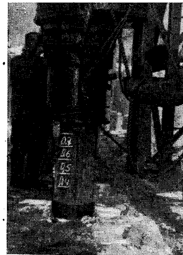
Рис. 6.4. Бурение скважины трубчатым буром
