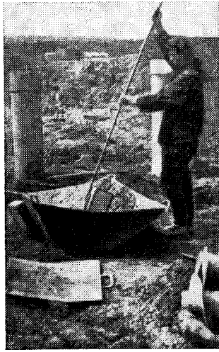
Рис. 14.14. Закладка взрывного заряда в скважину
